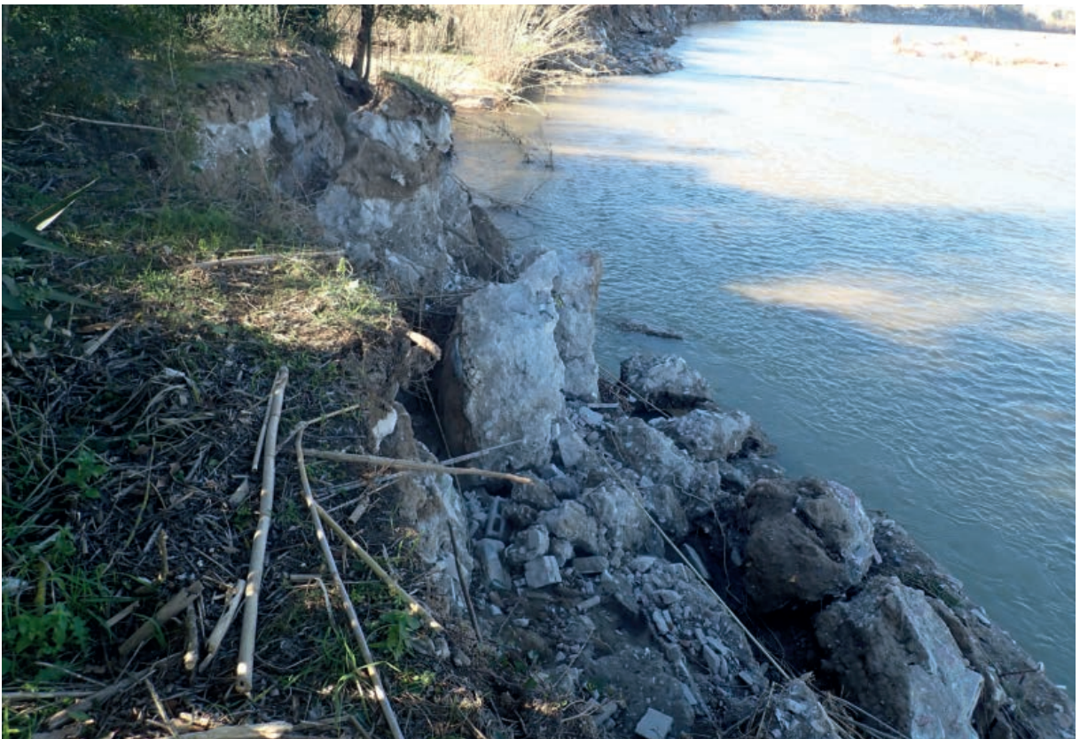
Fotografia 34. Soscavació a la llera a l'alçada de la BV 5122 pk 1.
