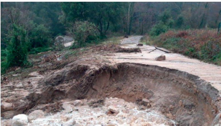
Fotografia 16. Zona d'arribada del corrent d'arrosegalls a les Roques de Morgadella. Font: Ajuntament de Riudarenes.
