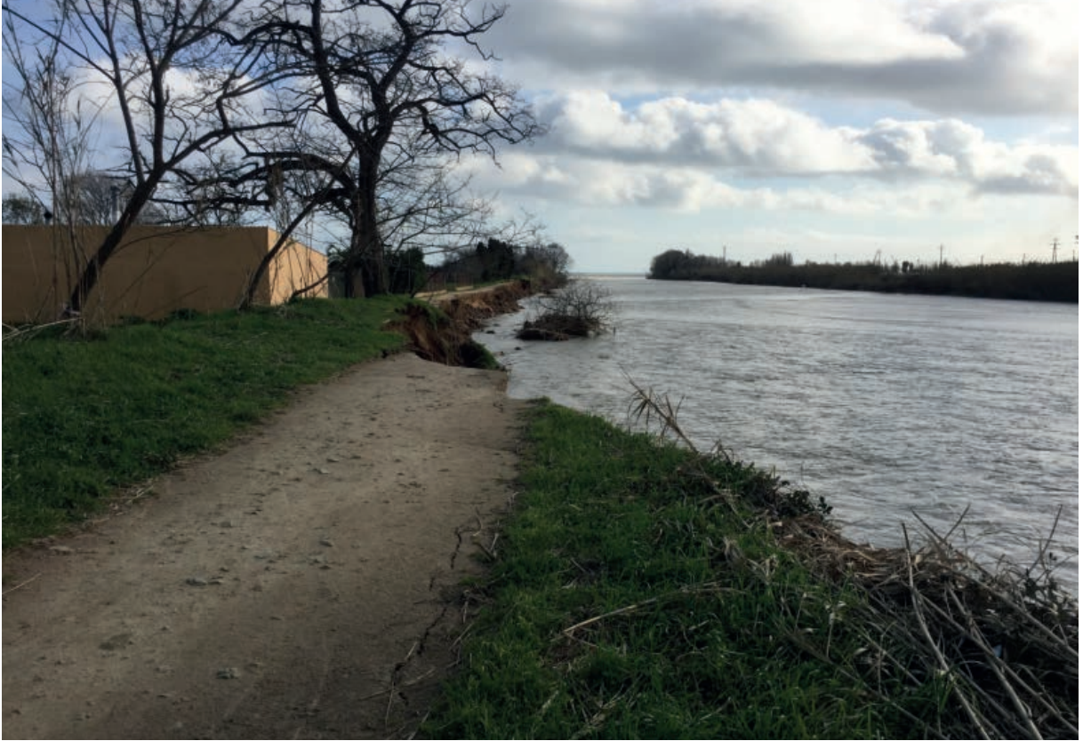
Fotografia 29. Escarpament per socavació al Camí de la Ribera.
