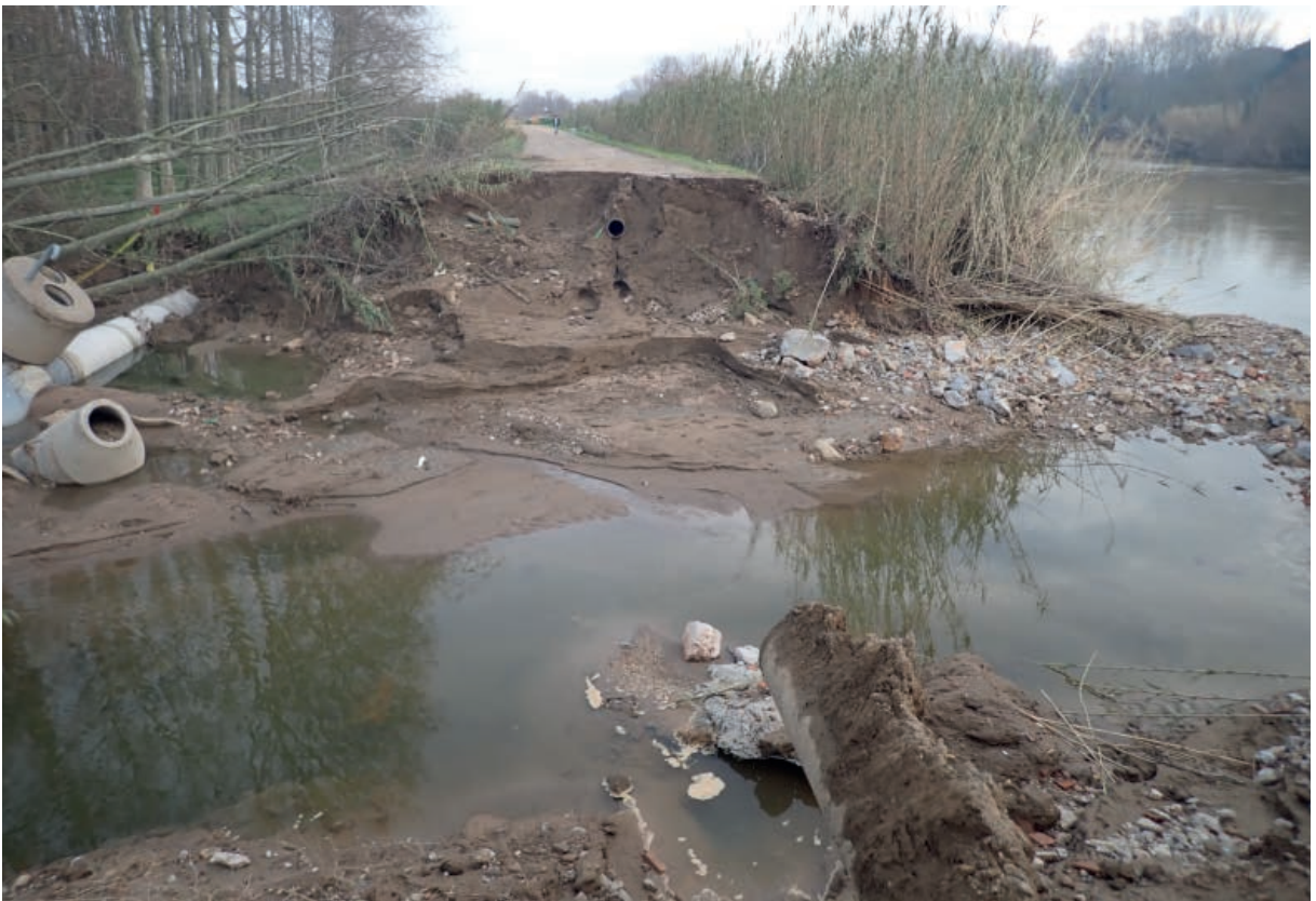
Fotografia 57. Trencament d'una canalització i del camí que va paral·lel a la vora esquerra del Ter, a l'alçada de Torroella de Montgrí.
