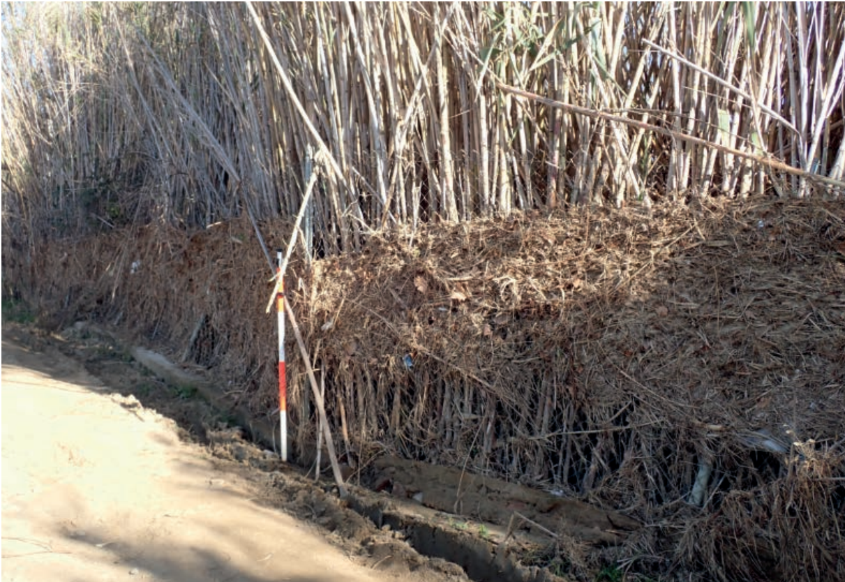
Fotografia 23. Evidència de l'alçada de la làmina d'aigua a les immediacions de la depuradora de Blanes.
