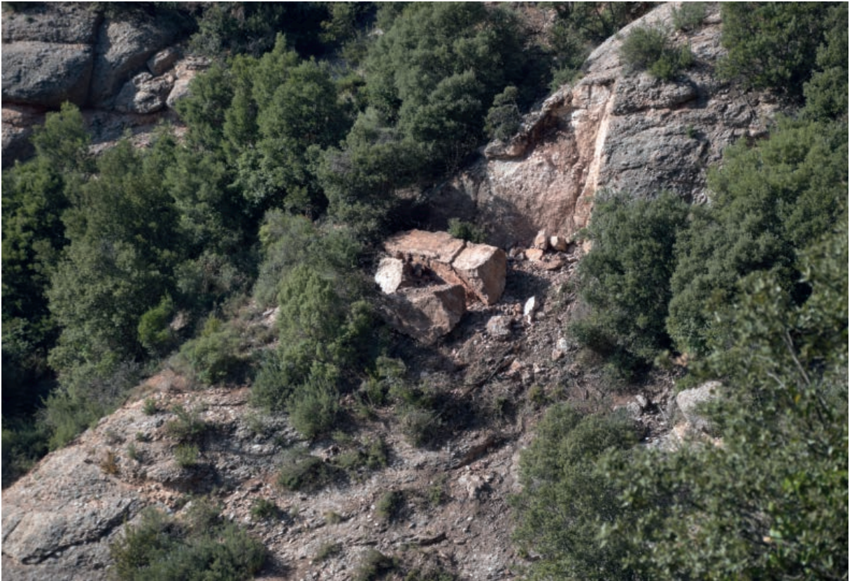
Fotografia 10. Despreniment proper al Torrent de les Grutes.
