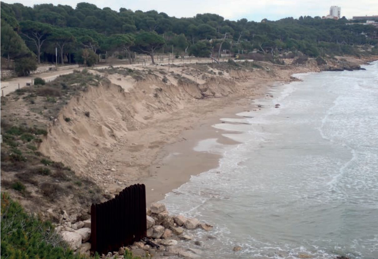
Fotografia 66. Erosió del talús de la Platja Llarga, Salou.
