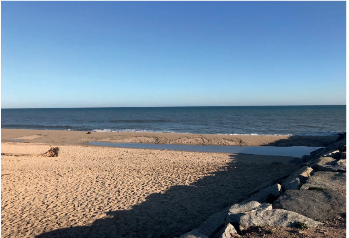
Fotografia 72. Acumulació de sediments al Port de Mataró.
