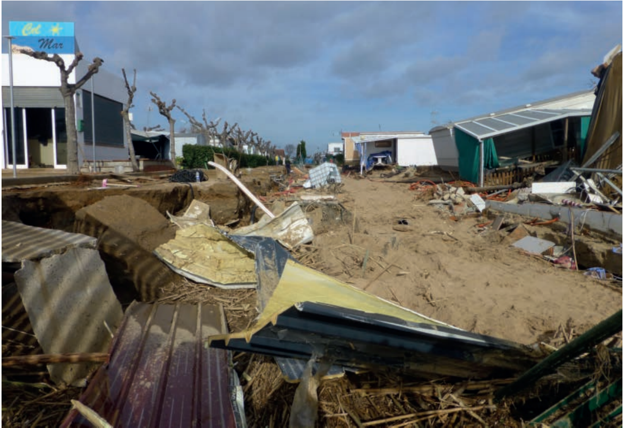
Fotografia 88. Afectacions al càmping Mar i Sol.
