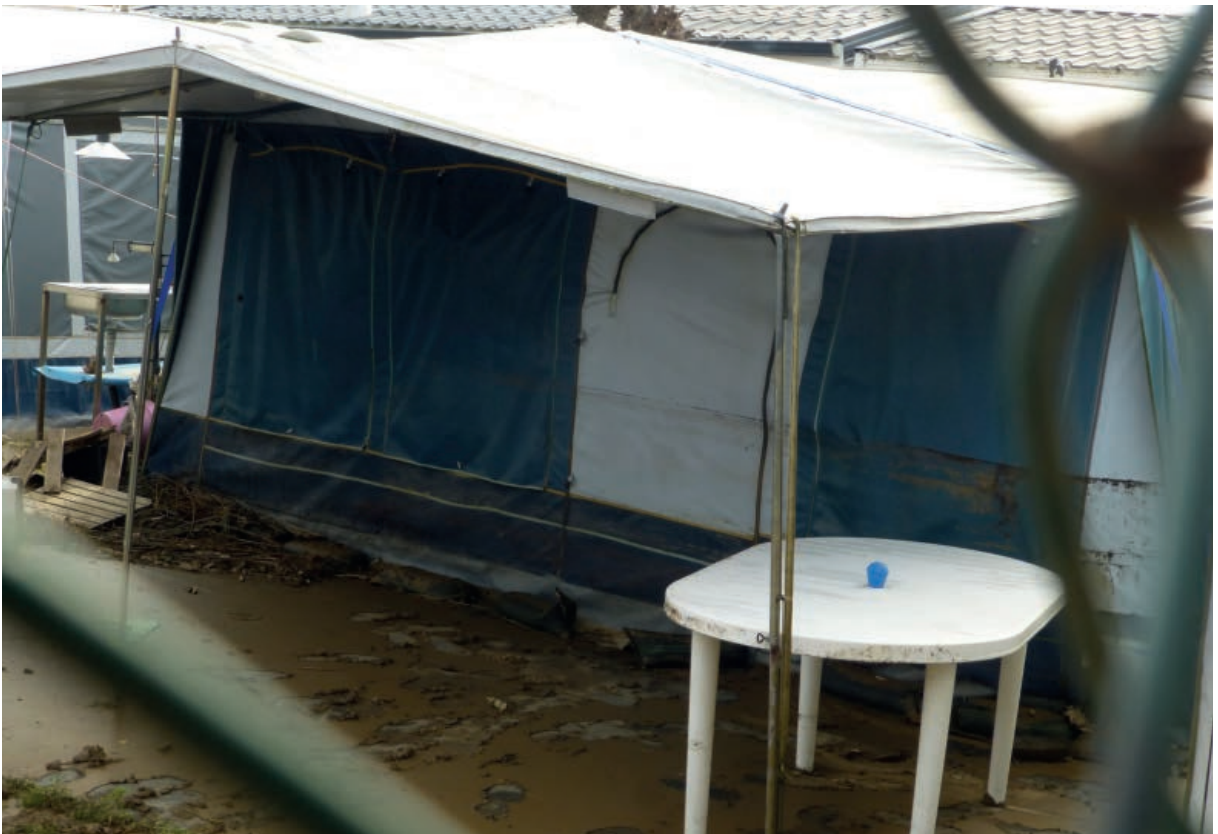
Fotografia 26. Evidència de l'alçada de la làmina d'aigua al Càmping Blaumar.
