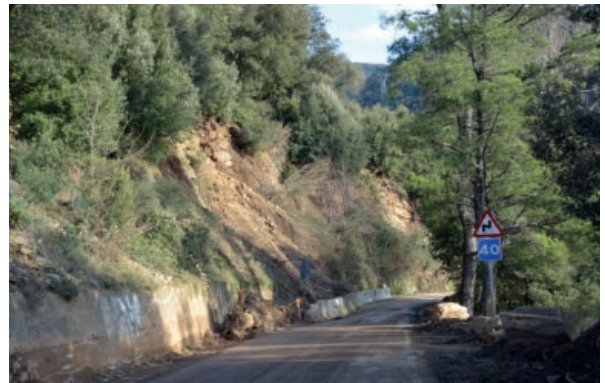
Fotografia 7. Eslavissada a la BV-5301 pk 17+290 (Montseny, Vallès Oriental). A l'esquerra, fotografia extreta de Google Maps amb data 26/07/2018. A la dreta, fotografia de 28/01/2020.
