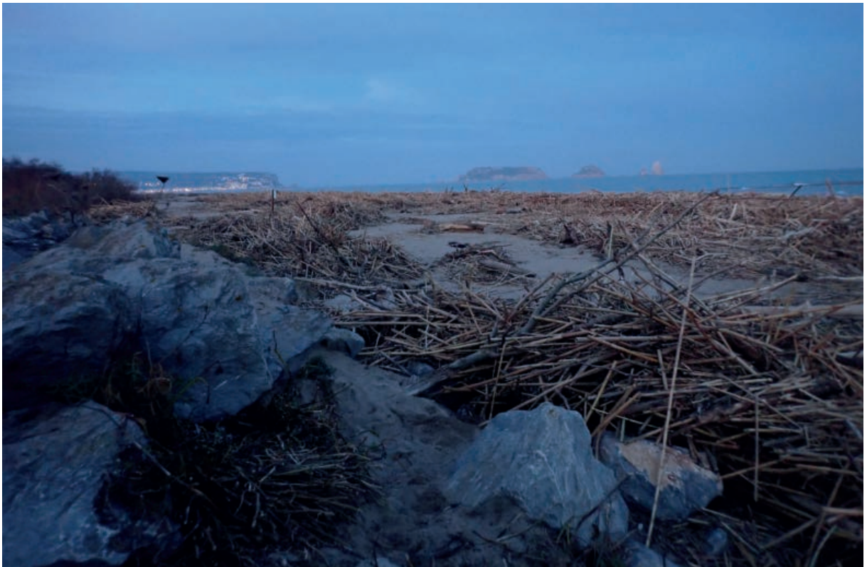
Fotografia 54. Gola del Ter: acumulació de flotants a l'escullera del marge esquerre del riu. Els dipòsits de platja que hi havia davant l'escullera han estat erosionats.
