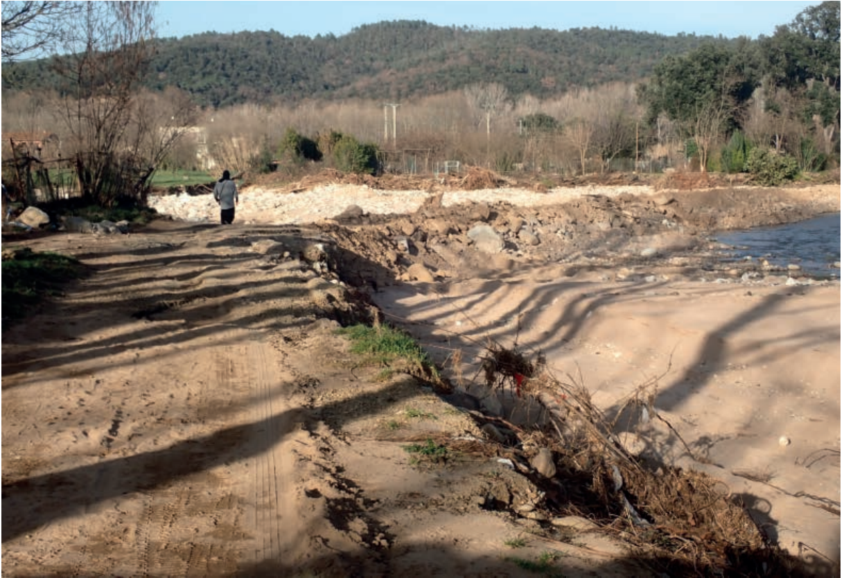
Fotografia 45. Bifurcació de la Riera d'Osor on l'aigua va sortir del seu curs natural obrint-se pas per la riba esquerra i formant una illa. A la imatge s'observa el camí que ja s'havia començat a refer i el curs d'aigua que havia recuperat la seva traça natural.
