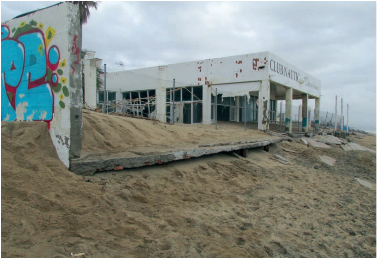
Fotografia 76. Acumulació de sorres i desperfectes ocasionats al Club Nàutic de Cabrera de Mar.
