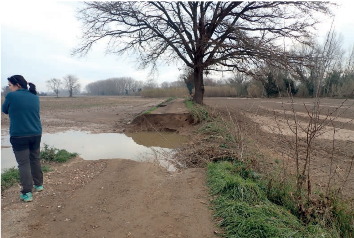
Fotografia 59. Camí de la ruta de la Riba del Ter. Trencament del camí. L'aigua s'ha obert pas d'un camp a l'altre erosionant i tallant per complet el camí que els separa. Sentit del flux cap a l'esquerre.
