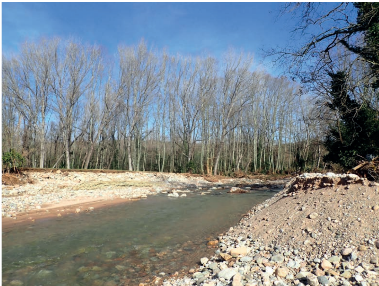
Fotografia 38. Erosió als dos marges del Ter just aigües avall de la confluència de la Riera d'Osor. S'observa el sediment de graves i sorres de la terrassa inferior del Ter.
