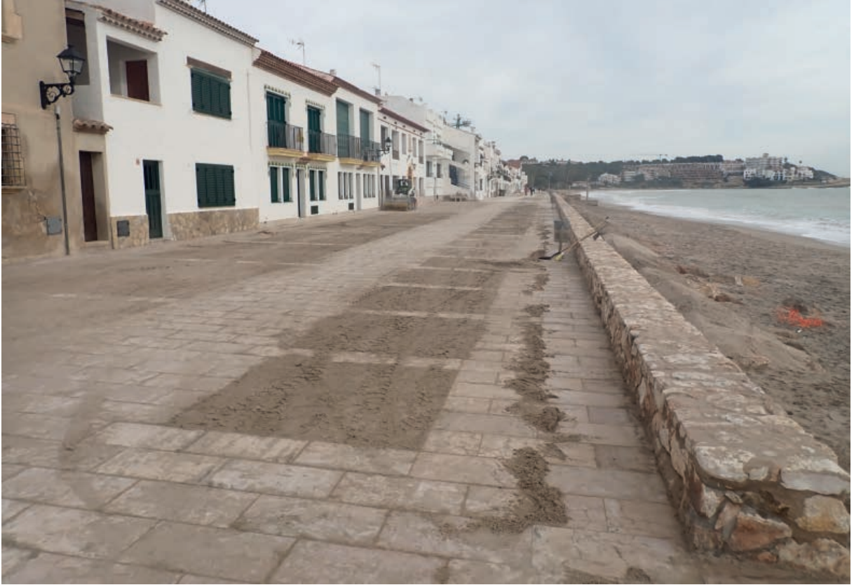
Fotografia 64. Acumulació de sorra al passeig marítim de la Platja d'Altavilla.
