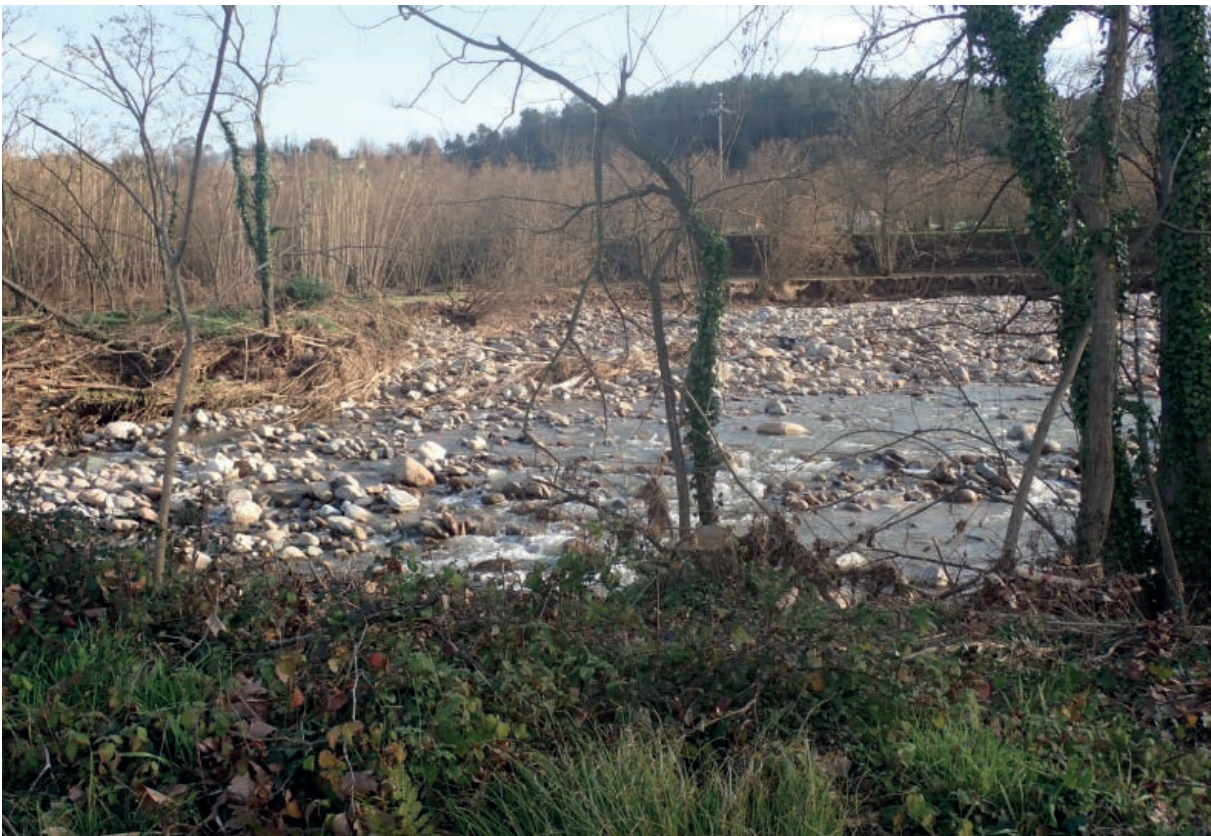
Fotografia 44. Soscavació dels marges de la llera de la Riera d'Osor degut a la presència de remolins d'aigua que actuen amb més força.
