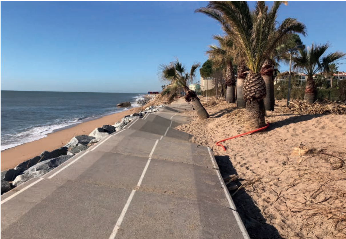
Fotografia 78. Erosió de la Platja de Pineda, afectacions carril bici, Pineda de Mar.
