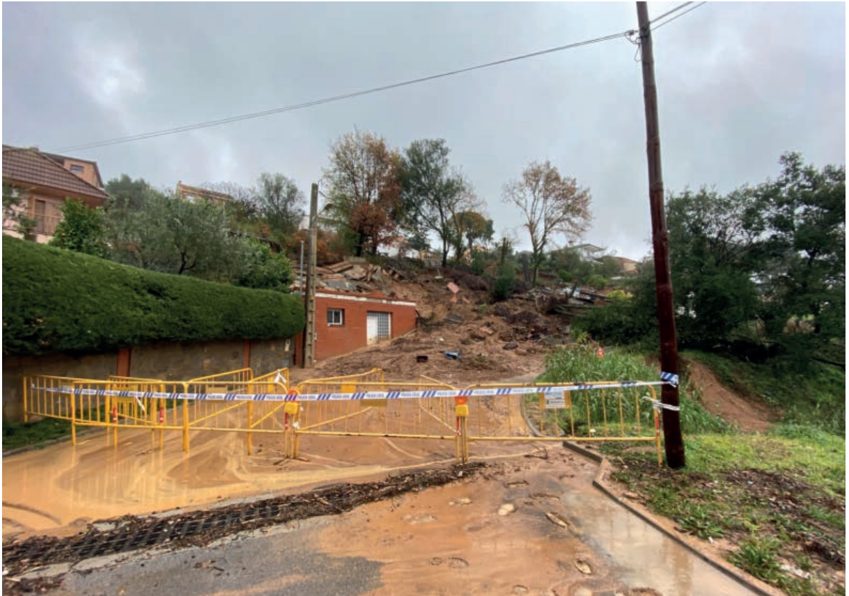
Fotografia 5. Cases destruïdes a Cànoves i Samalús. Font: https://twitter.com/cserradomenech/status/1219938142242951168 .
