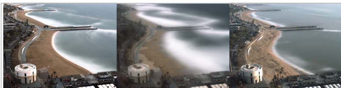
Figura 15. Imatges de la platja de Nova Icària abans (esquerra), durant (centre) i després (dreta) de la tempesta Glòria. Malgrat la presència dels espigons de protecció, la platja va quedar inundada durant el temporal i s'aprecia un retrocés de línia de costa.
