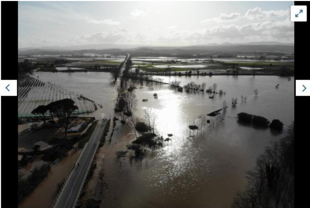
El pont del Ter a Verges, completament negat i inutilitzat MOSSOS D'ESQUADRA
